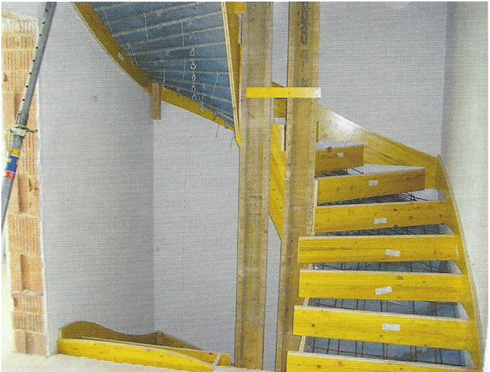
Das neue Schalsystem für Ortbetontreppen ist so angelegt, dass es nahezu perfekte Ergebnisse ermöglicht
